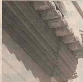
Fig. 1. Acabamento do beiral em cimalha. Fonte: Etec Laguna IPHAN/SC
