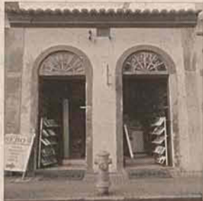
Fig. 4. Fachada Rua Osvaldo Cabral. Fonte: Etec Laguna IPHAN/SC
