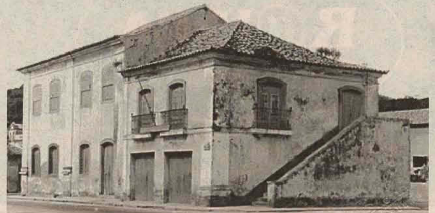
Fig. 2. Edificação antes da primeira obra de restauração. Autor: Desconhecido. Arquivo: Etec Laguna IPHAN/SC
