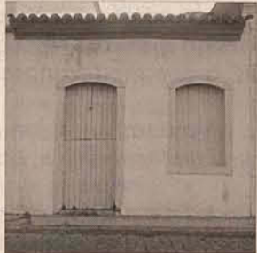
Fig. 3. Fachada Rua Fernando Machaco. Fonte: Etec Laguna IPHAN/SC
