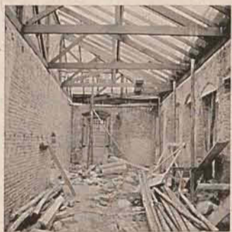
Fig. 3. Foto da obra de restauro em 1997. Fonte: Etec Laguna IPHAN/SC
