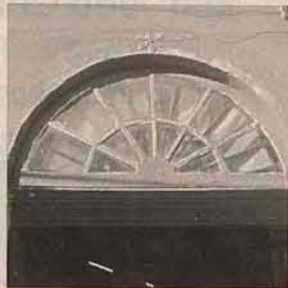
Fig. 2. Porta com bandeira em arco pleno. Fonte: Etec Laguna IPHAN/SC
